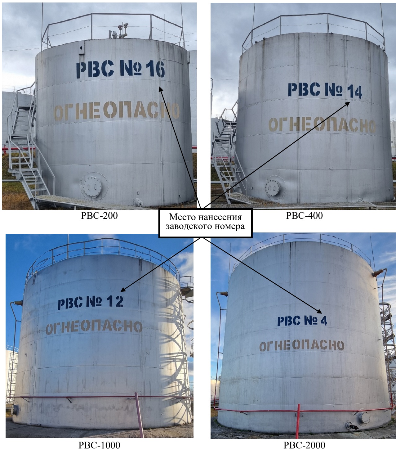
Рисунок 1 – Общий вид резервуаров
