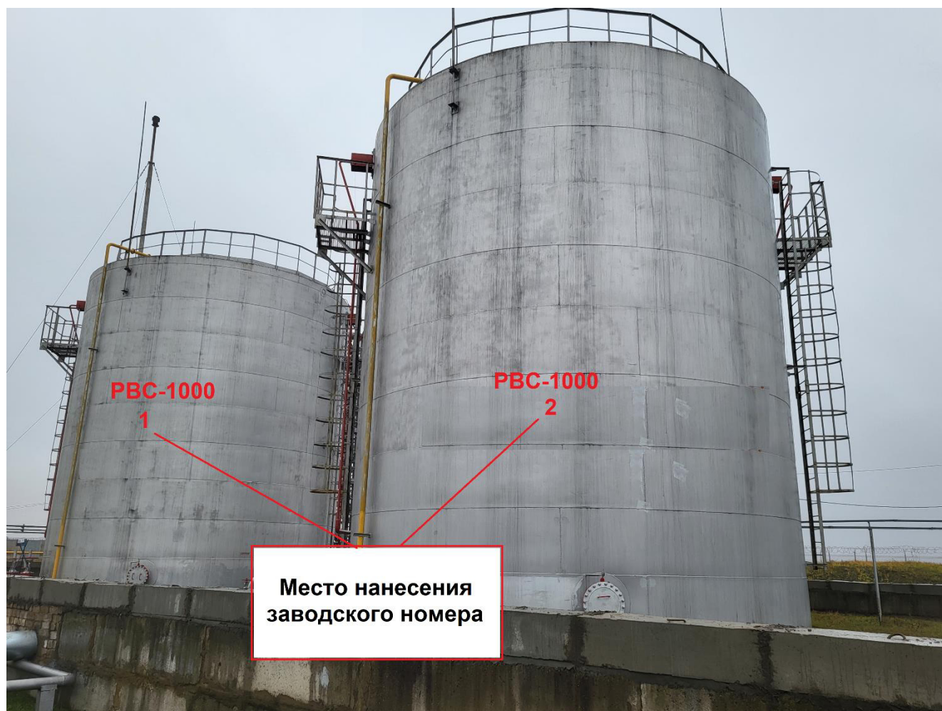
Рисунок 1 - Общий вид резервуаров вертикальных стальных цилиндрических PVC-1000 с указанием места нанесения заводского номера
