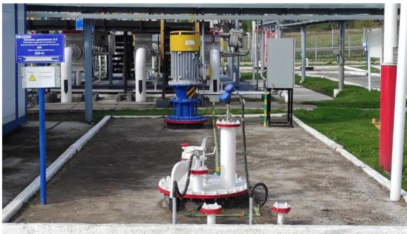
Рисунок 2 – Общий вид резервуара ЕП40-2400-1-2К
