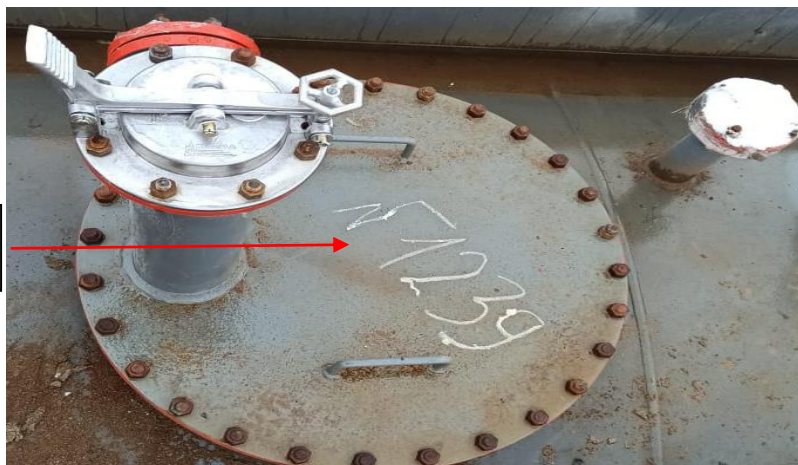
Рисунок 4 – Фотография горловины и заводского номера резервуара стального горизонтального цилиндрического РГС, модификации РГС-63 с зав. №1239
