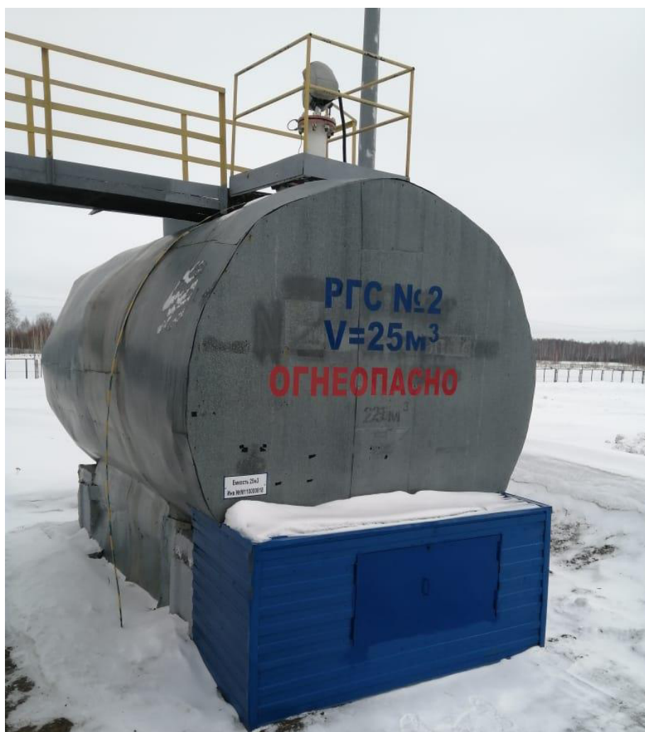
Рисунок 2 – Общий вид резервуара РГС-25
