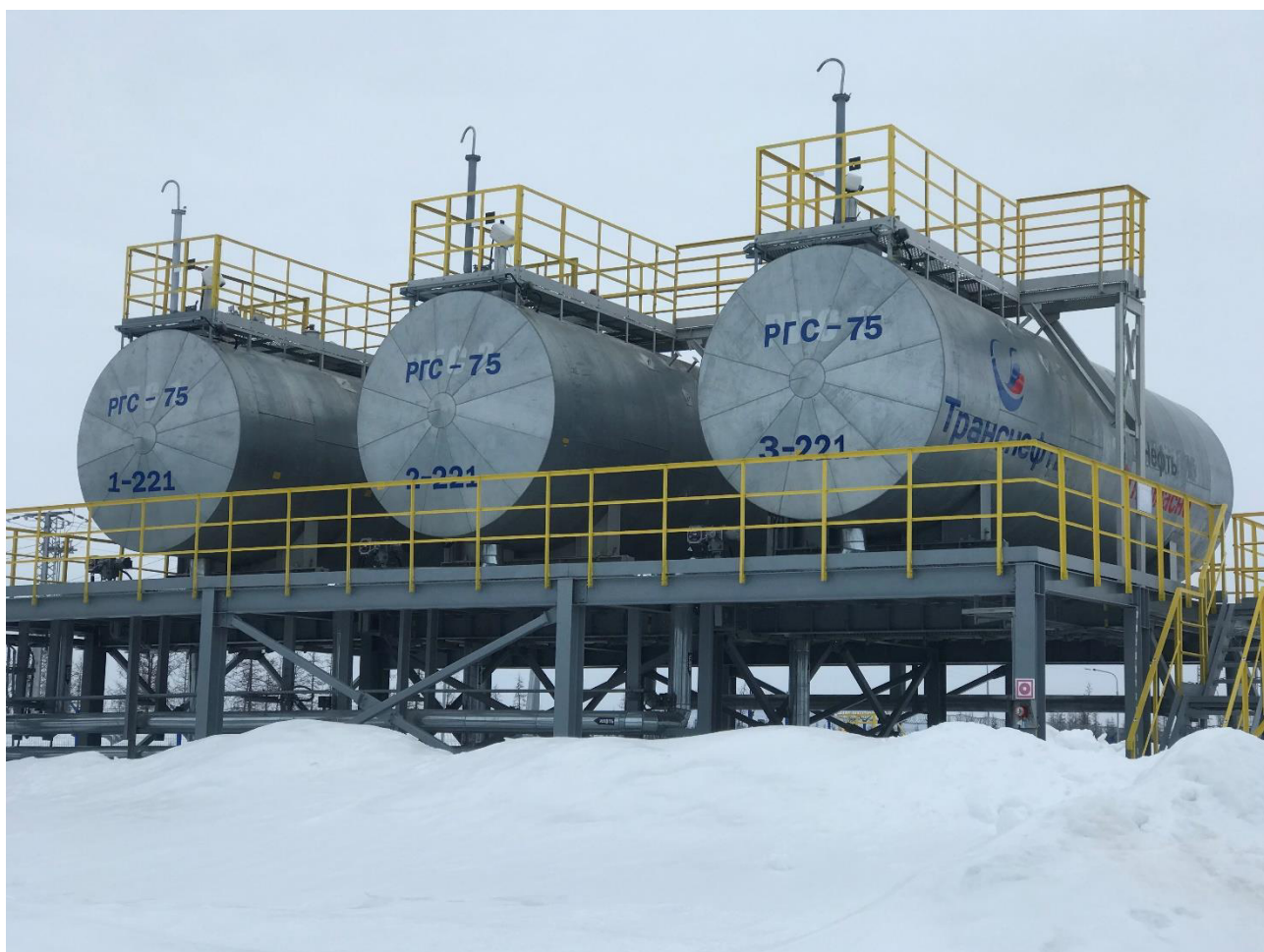
Рисунок 1 – Общий вид резервуаров PGC-75
