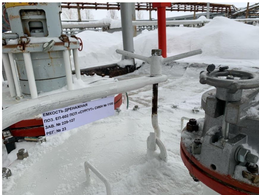
Рисунок 3 – Место нанесения заводского номера резервуара РГС-8
