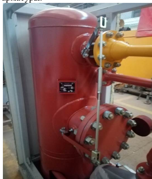
Рис. 2а – Внешний вид сепаратора «ЦИКЛОН» вертикального расположения
