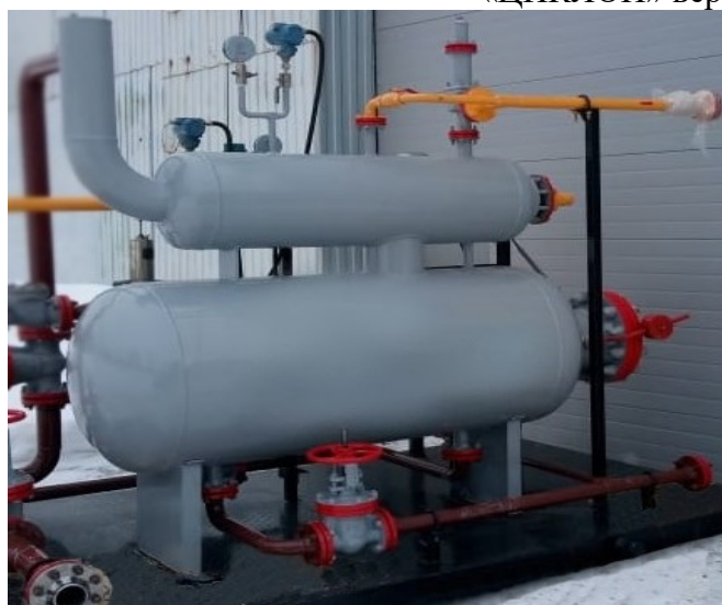
Рис. 2б – Внешний вид сепаратора «ЦИКЛОН» горизонтального расположения
