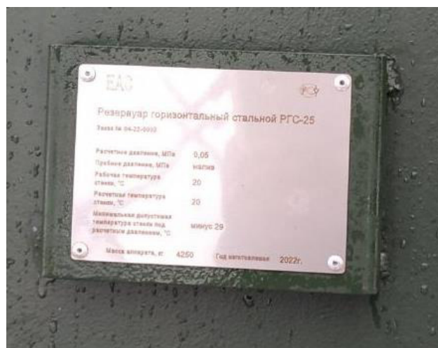
Рисунок 1 - Место нанесения заводского номера резервуара
