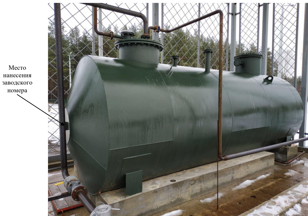
Рисунок 2 - Общий вид резервуара
