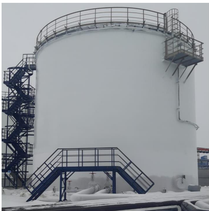
Рисунок 1 – Общий вид резервуара РВСП-2000 №6
