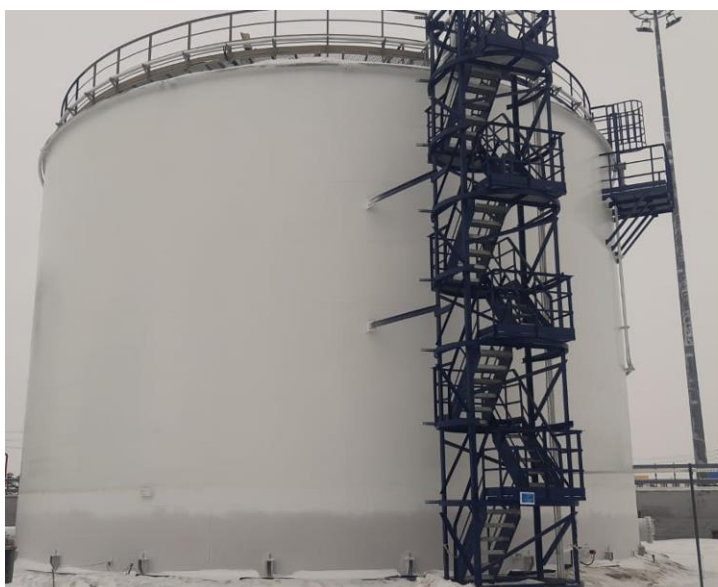
Рисунок 1 – Общий вид резервуара РВСП-3000 №8
