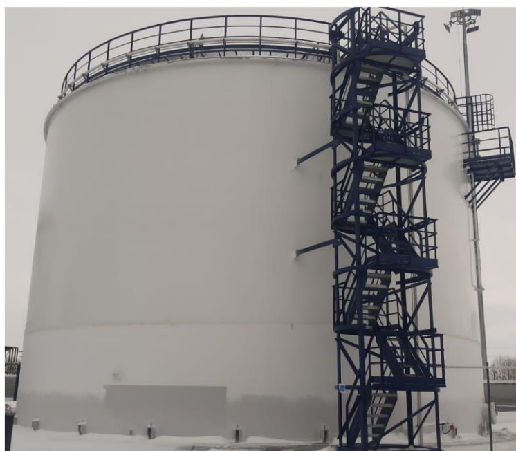
Рисунок 4 – Общий вид резервуара РВСП-3000 №11
