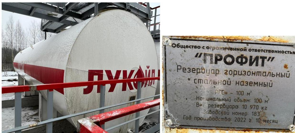
Рисунок 7 – Общий вид резервуара РГСн-100 зав.№ 183
