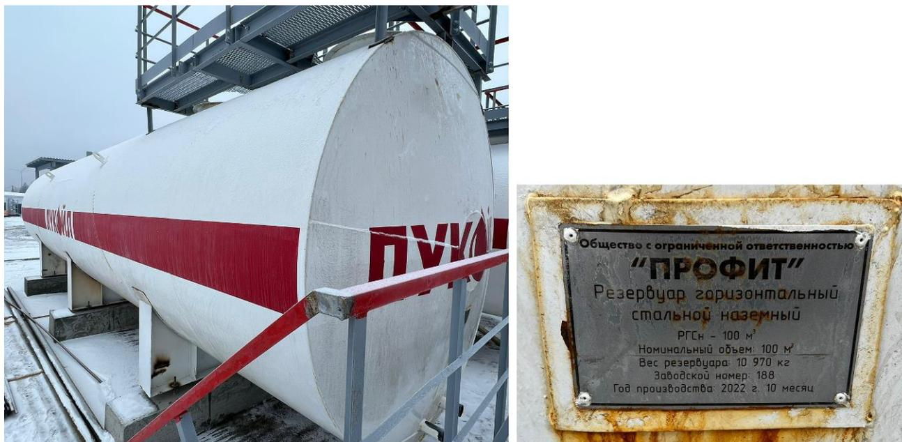
Рисунок 12 – Общий вид резервуара РГСн-100 зав.№ 188
