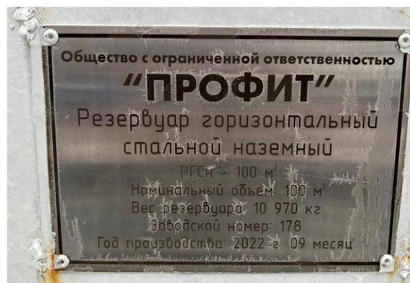
Рисунок 2 – Общий вид резервуара РГСн-100 зав.№ 178
