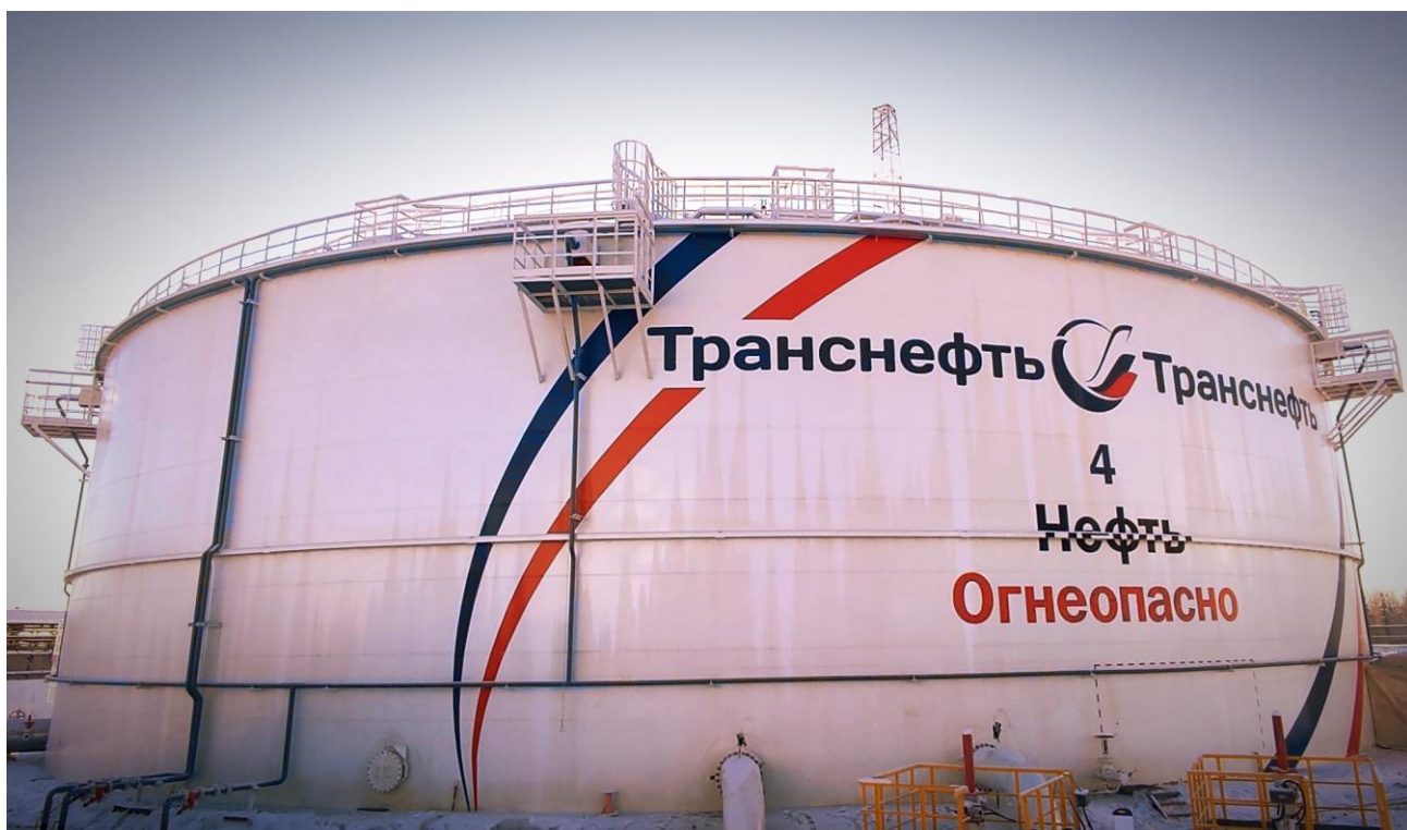
Рисунок 1 – Общий вид резервуара РВСП-20000 зав.№4
