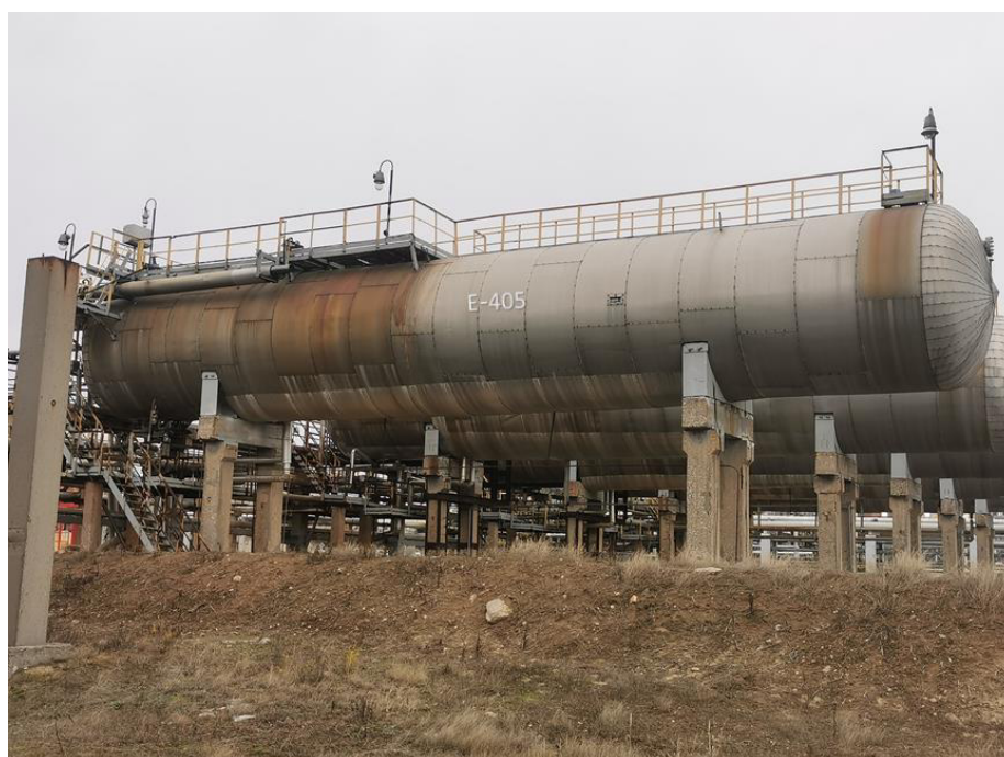
Рисунок 1 – Общий вид резервуара РГС-200
