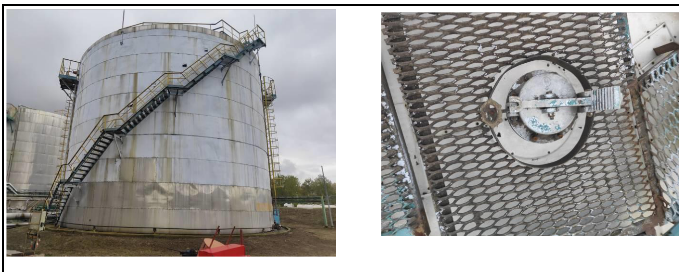
Рисунок 8 – Общий вид резервуара РВС-2000 (№427) с замерным люком
