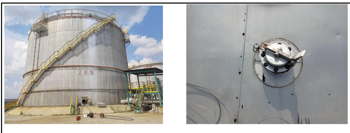
Рисунок 9 – Общий вид резервуара РВС-10000 (№203) с замерным люком
