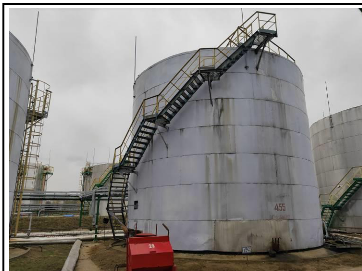
Рисунок 4 – Общий вид резервуара РВС-700 (№455) с замерным люком
