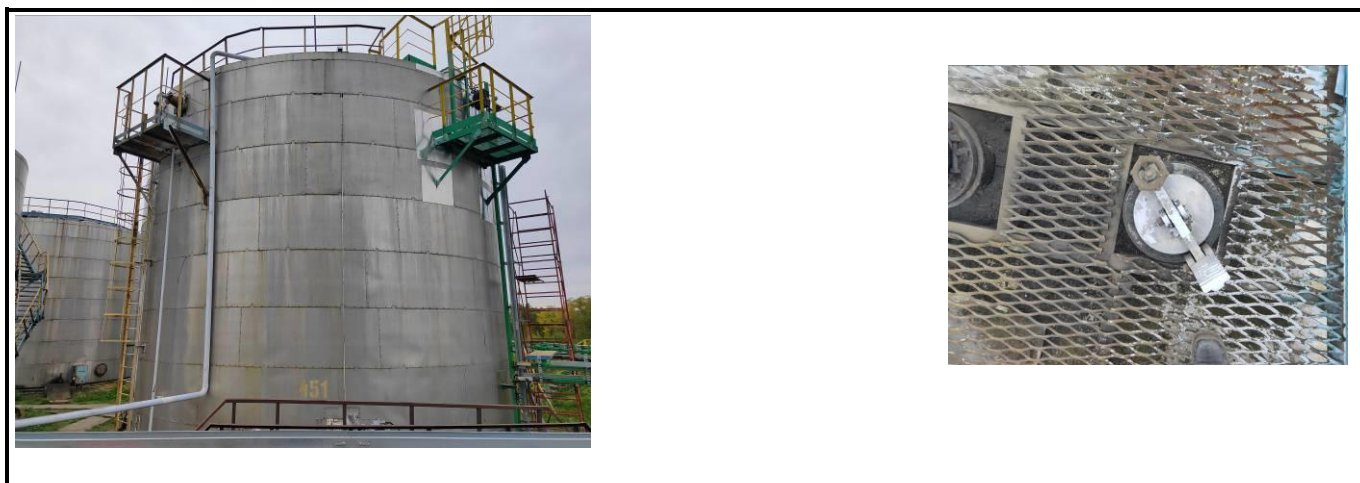
Рисунок 3 – Общий вид резервуара РВС-700 (№451) с замерным люком
