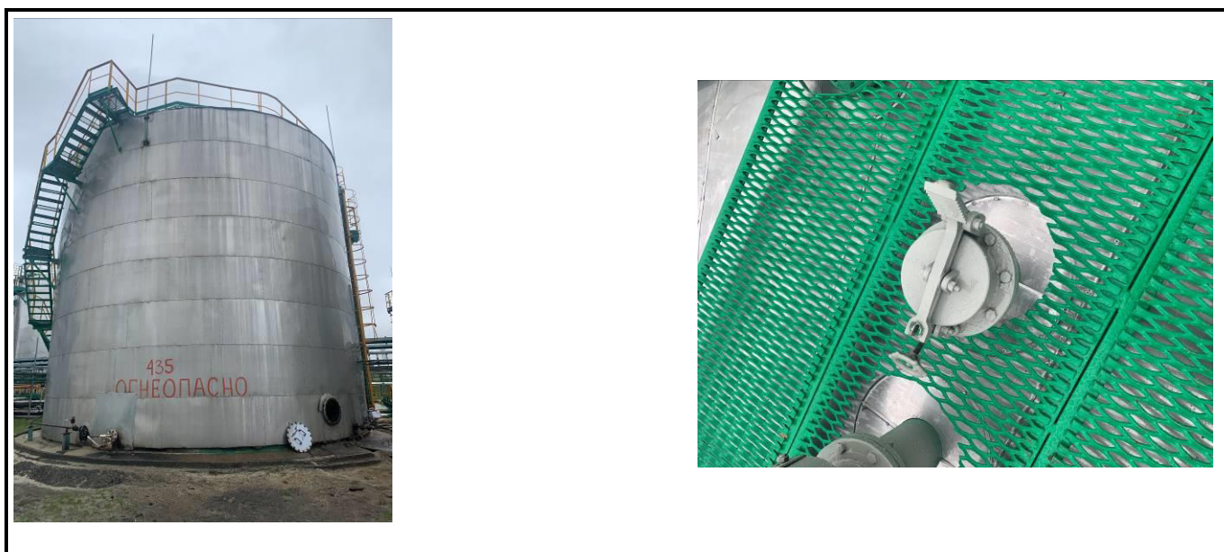
Рисунок 2 – Общий вид резервуара РВС-700 (№435) с замерным люком
