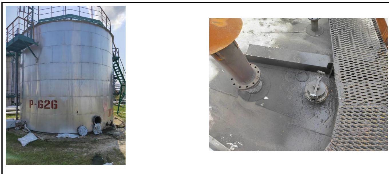
Рисунок 1 – Общий вид резервуара РВС-400 (№626) с замерным люком
