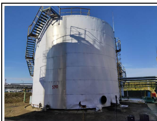
Рисунок 6 – Общий вид резервуара РВС-700 (№530) с замерным люком
