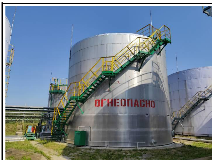
Рисунок 5 – Общий вид резервуара РВС-700 (№529) с замерным люком
