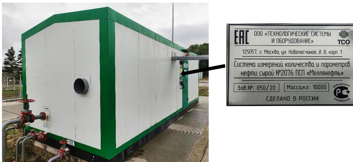
Рисунок - 1 Общий вид СИКНС и место нанесения заводского номера
