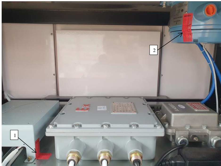
Рисунок 3 – Место пломбирования контроллера (1) и вычислителя (2) расходомера
