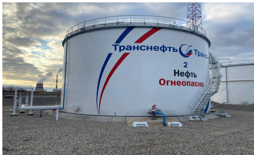
Рисунок 1 - Общий вид резервуара стального вертикального цилиндрического РВС-5000
