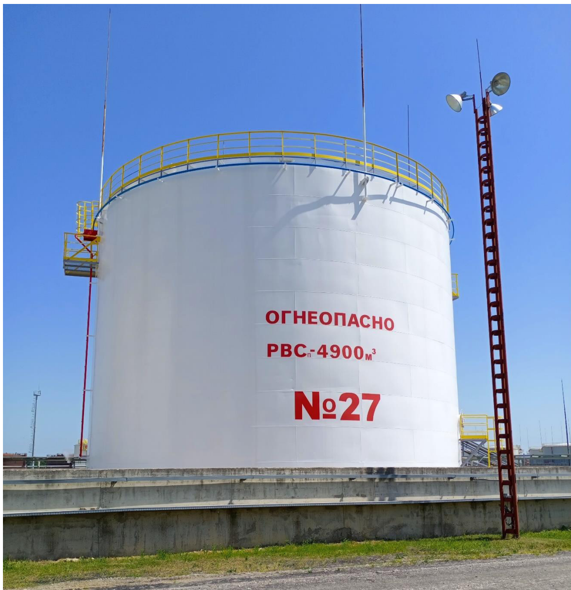
Рисунок 3 - Фотография общего вида резервуара РВСП-4900 заводской номер 27
