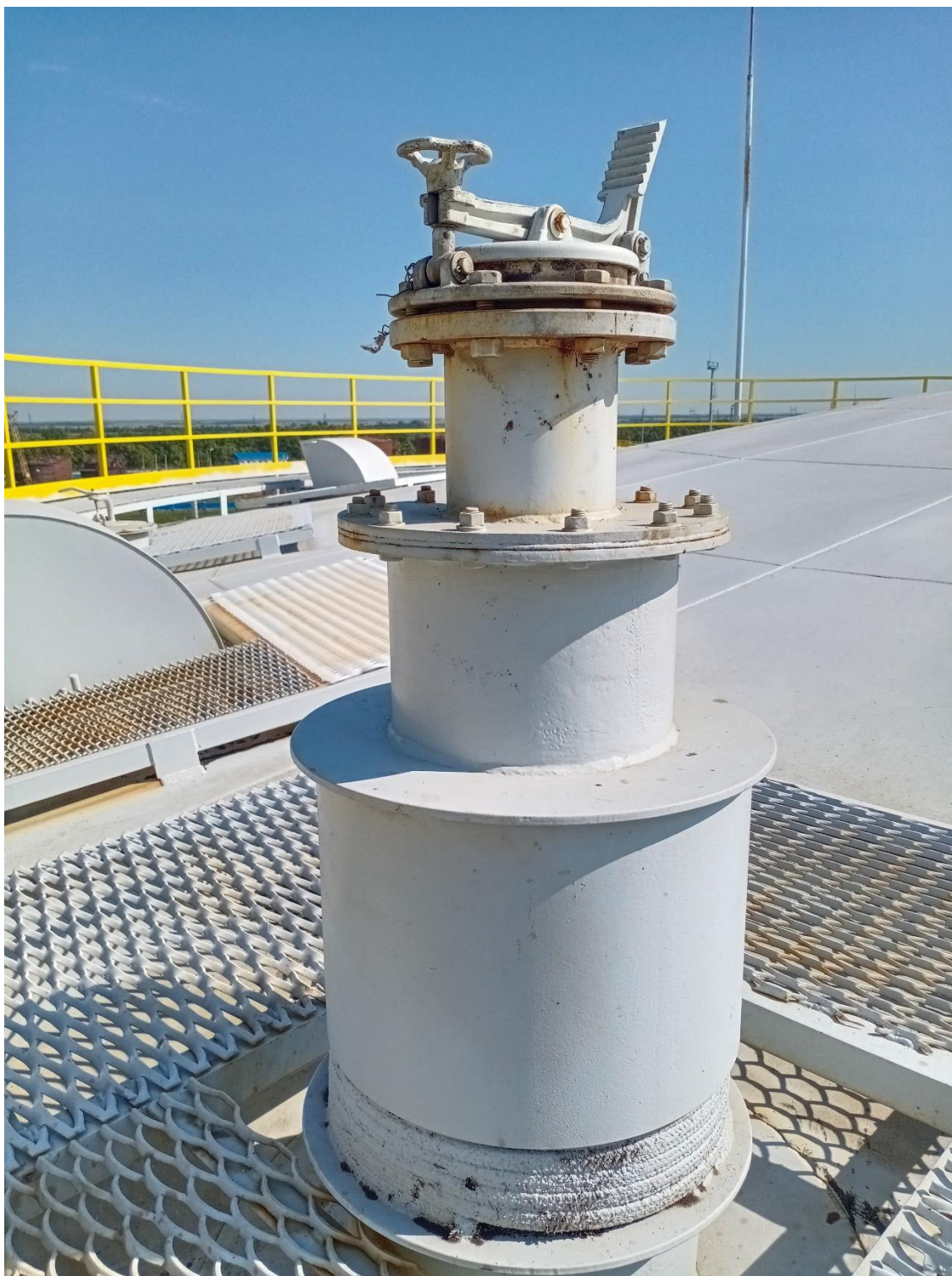
Рисунок 2 - Фотография крышки замерного люка резервуара РВСП-4900 заводской номер 26
