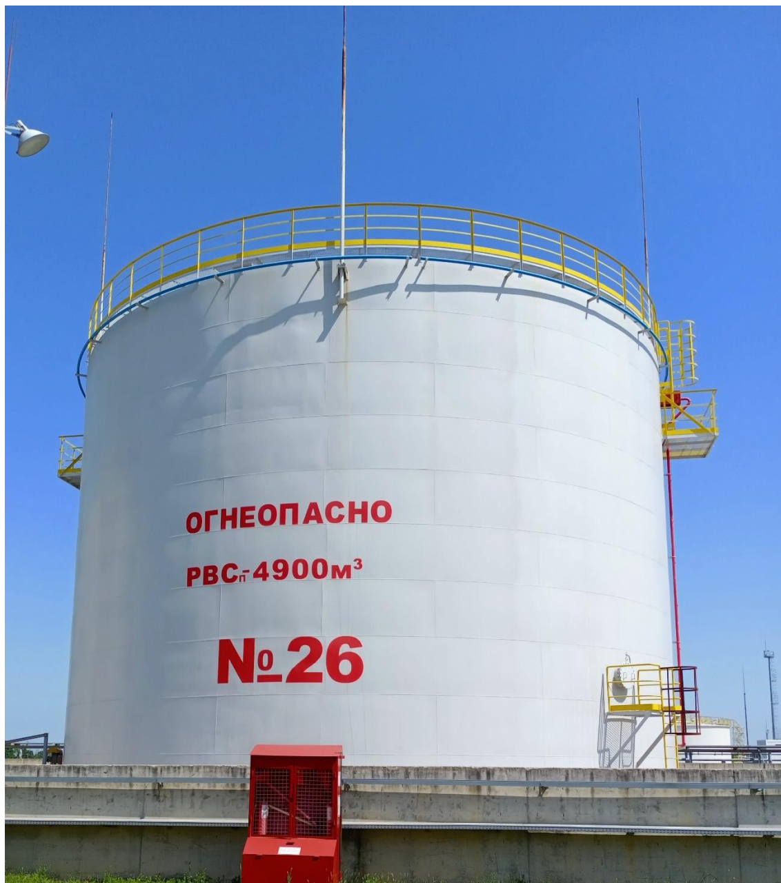
Рисунок 1 - Фотография общего вида резервуара РВСП-4900 заводской номер 26
