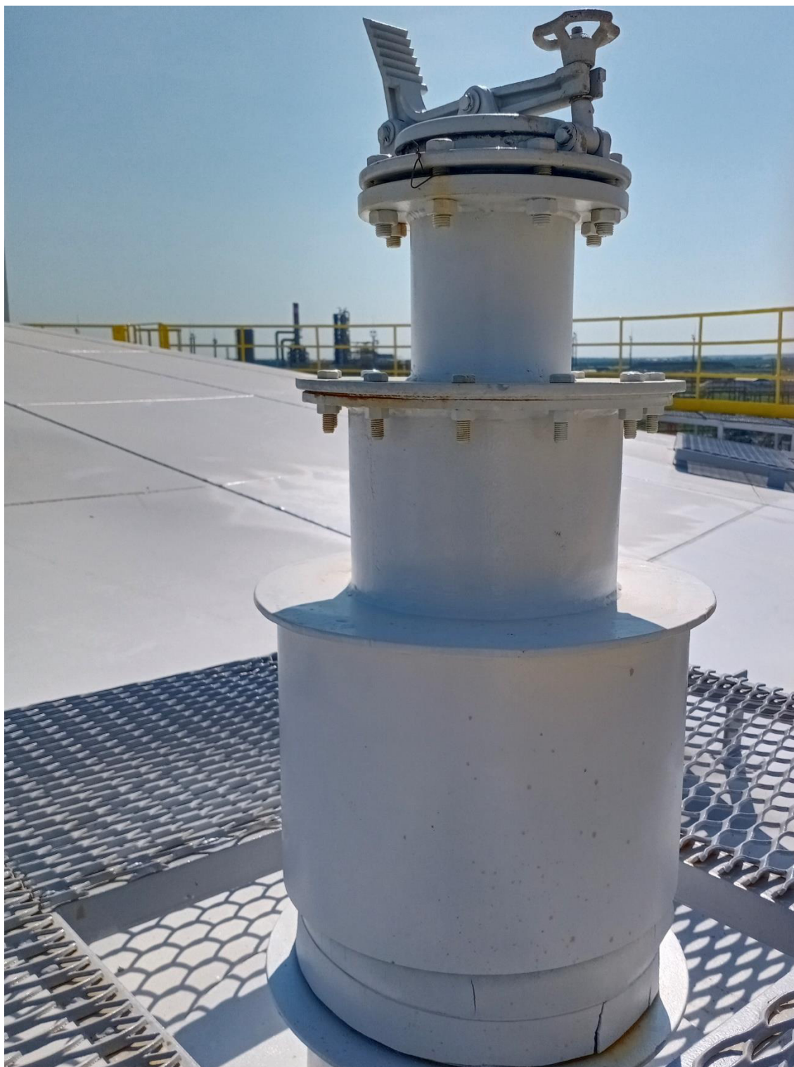
Рисунок 4 - Фотография крышки замерного люка резервуара РВСП-4900 заводской номер 27
