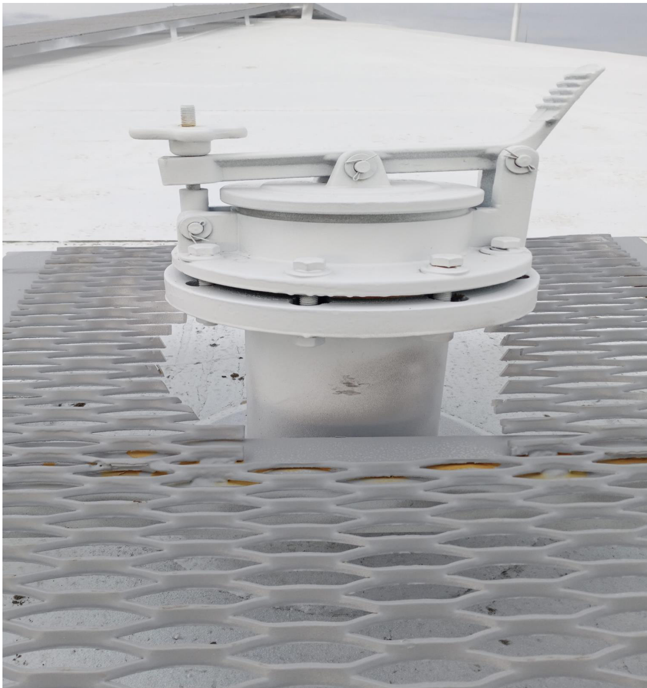
Рисунок 2 - Фотография крышки замерного люка резервуара РВС - 4950 заводской номер 36
