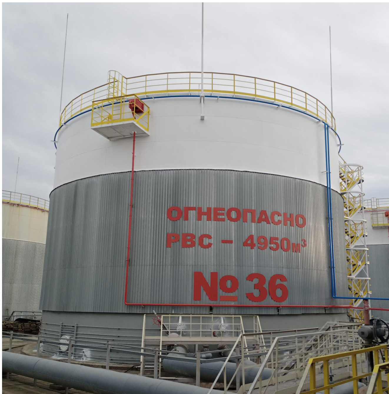
Рисунок 1 - Фотография общего вида резервуара РВС - 4950 заводской номер 36
