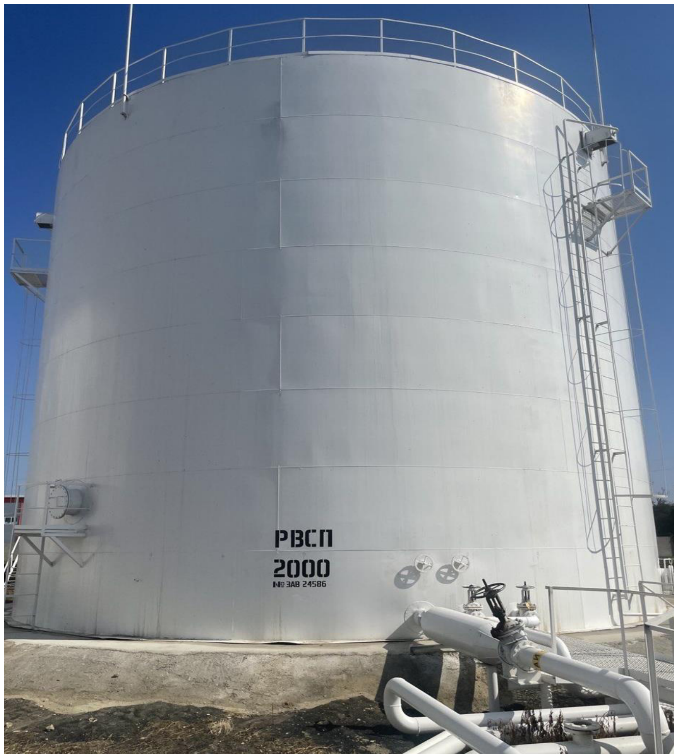
Рисунок 1 - Фотография общего вида резервуара РВСП-2000 заводской номер 24586
