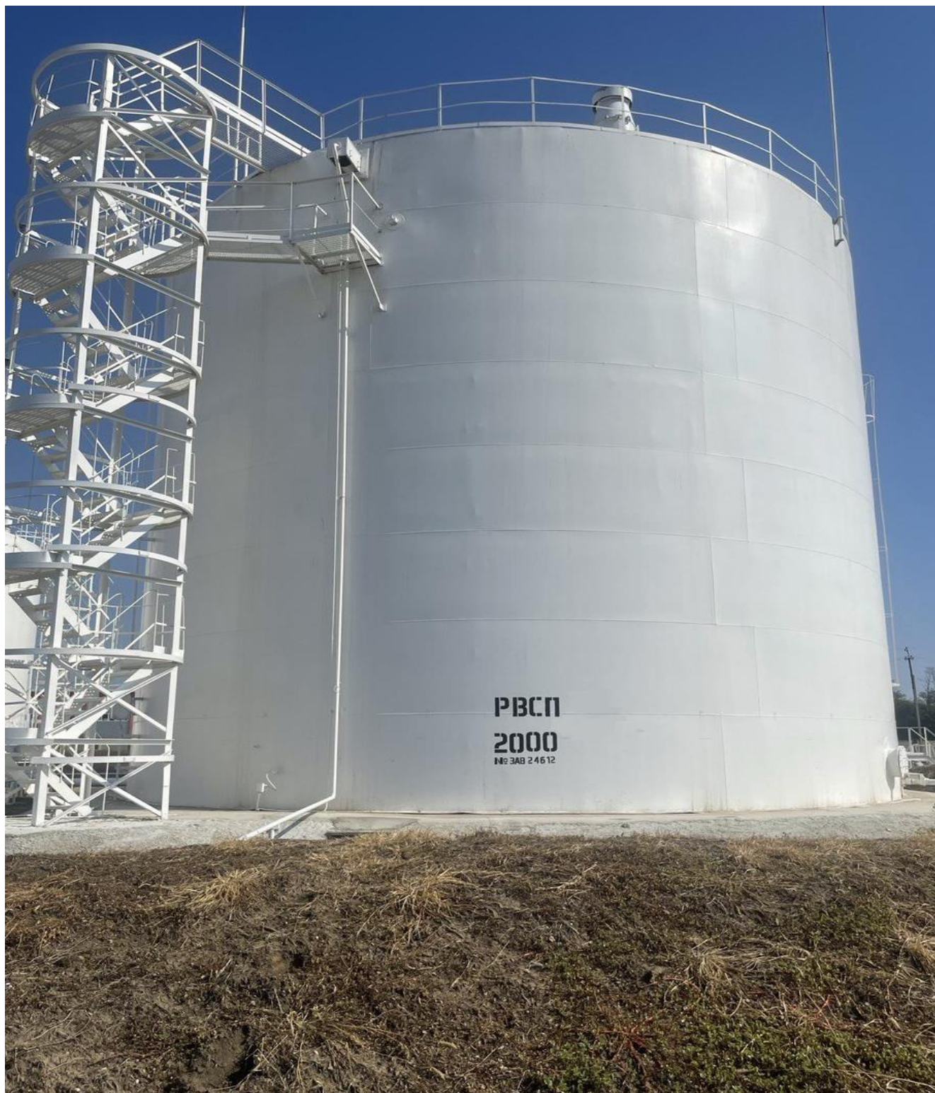
Рисунок 2 - Фотография общего вида резервуара РВСП-2000 заводской номер 24612
