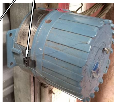
Рисунок 1 - Схема пломбировки счетчиков-расходомеров массовых SMF300 а) преобразователь 2700, б) преобразователь RFT 9739
