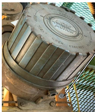
Рисунок 1 - Схема пломбировки счетчиков-расходомеров массовых SMF300 а) преобразователь 2700, б) преобразователь RFT 9739
