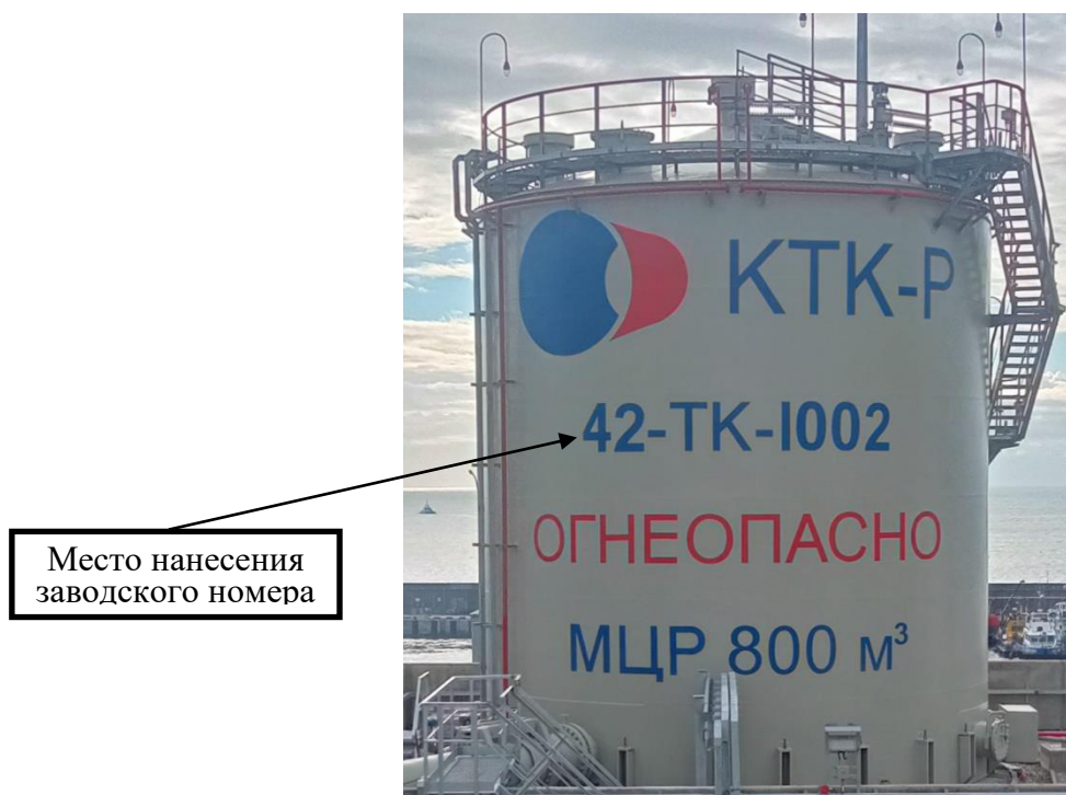
Рисунок 1 – Общий вид резервуара
