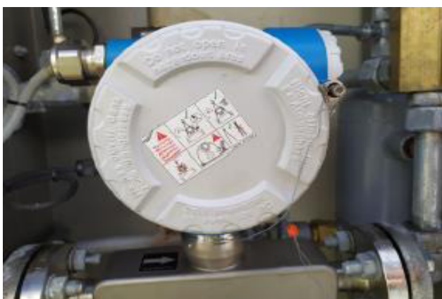
Рисунок 7 – Пломбирование расходомера массового Promass
