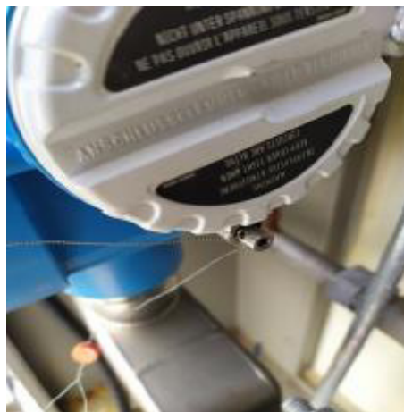
Рисунок 6 – Пломбирование расходомера массового LPGmass
