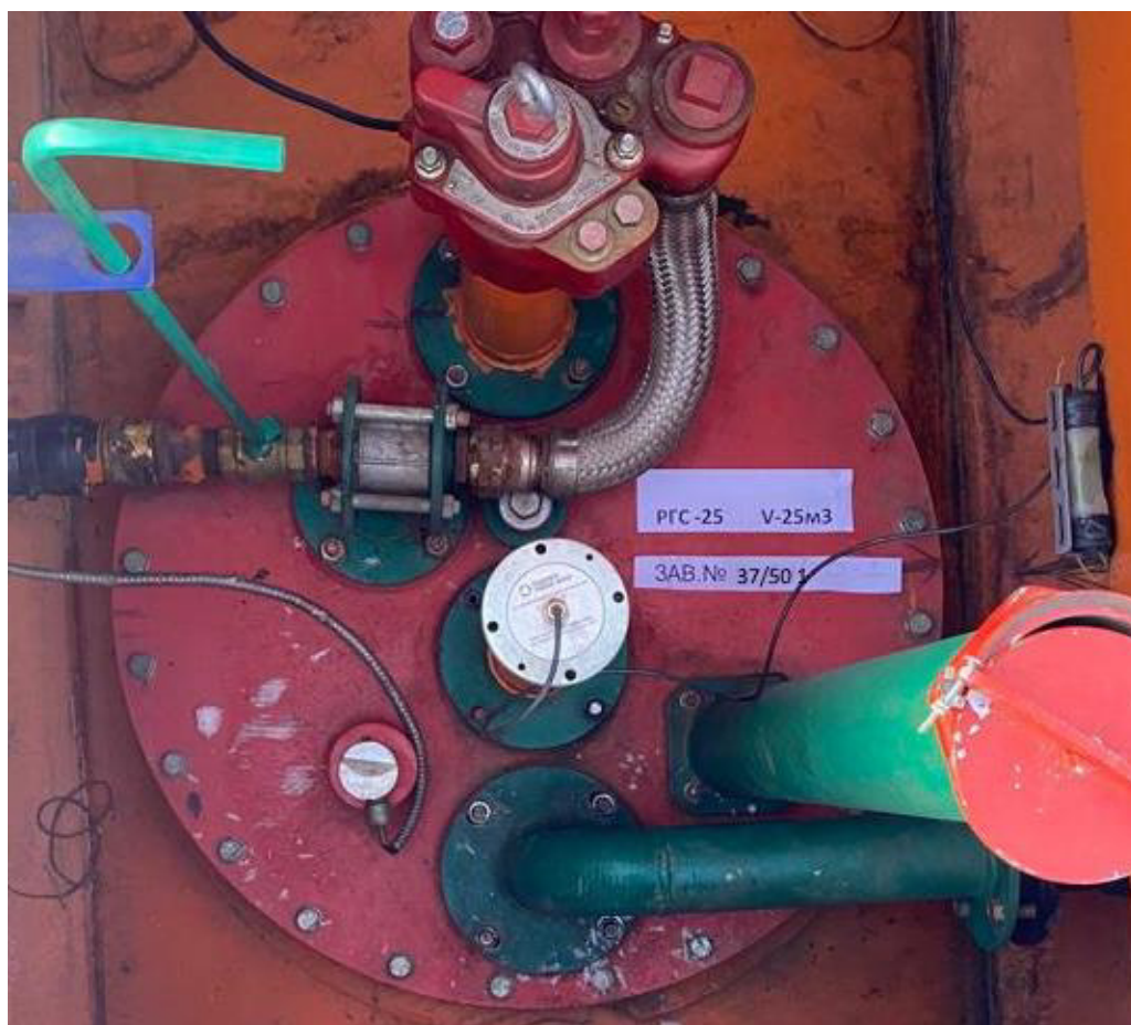
Рисунок 2 – Горловина резервуара РГС-25 зав.№ 37/501
