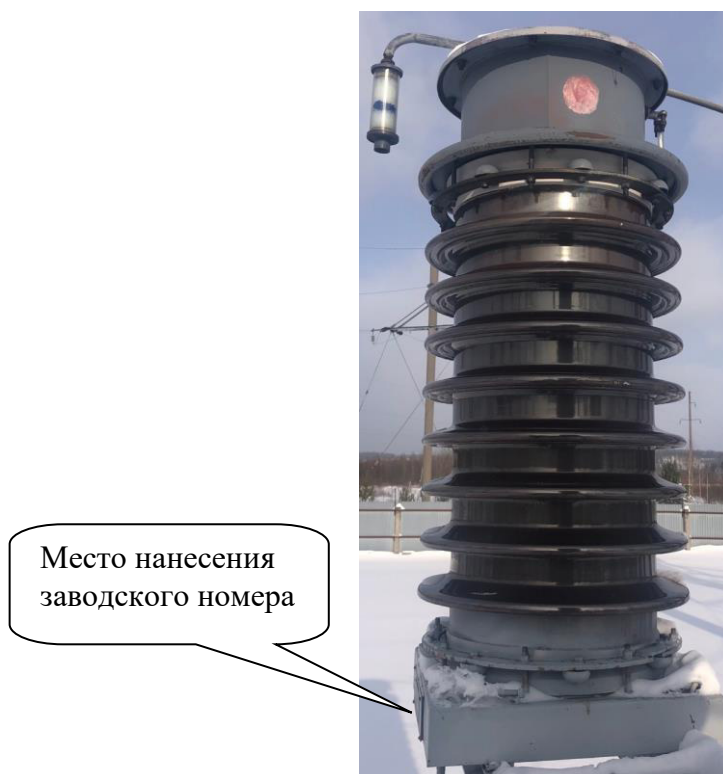
Рисунок 1 – Общий вид трансформатора с указанием места нанесения заводского номера Пломбирование трансформаторов не предусмотрено.
