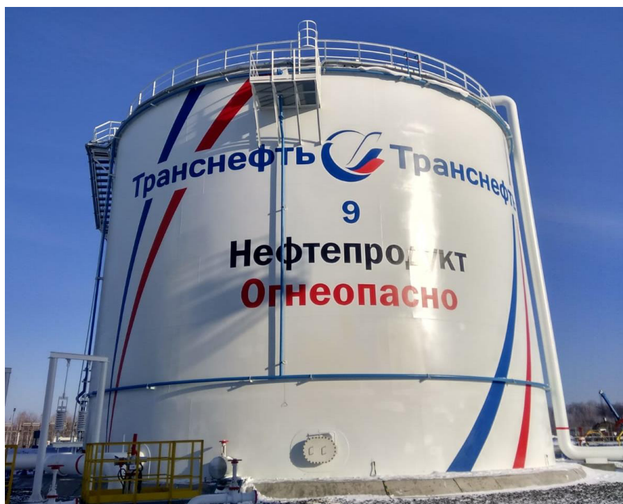
Рисунок 2 – Общий вид резервуара РВС-5000 №9
