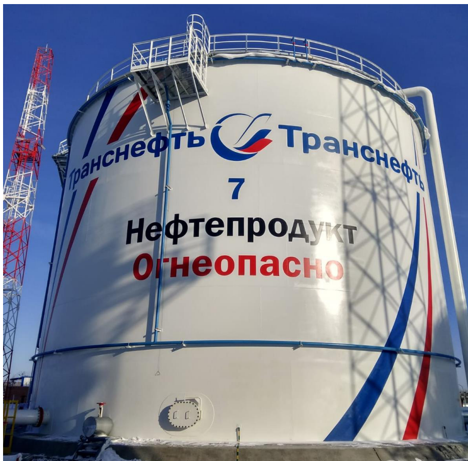
Рисунок 1 – Общий вид резервуара РВС-5000 №7
