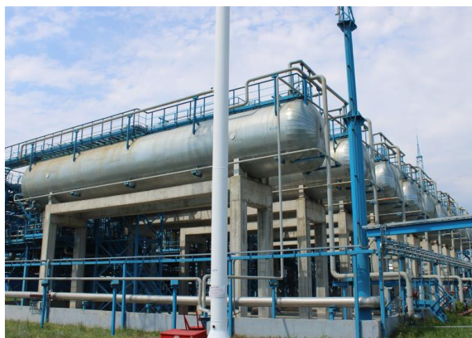
Рисунок 1 – Общий вид резервуаров
