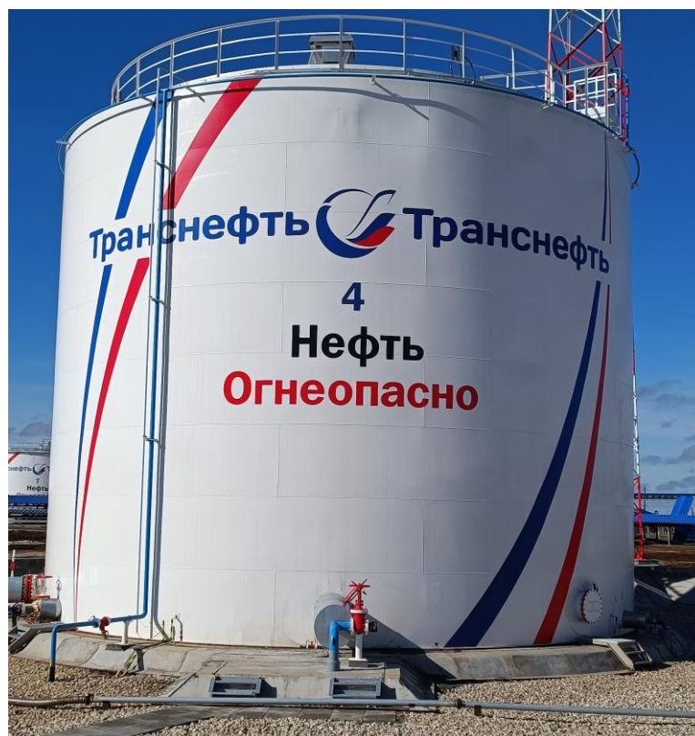
Рисунок 2 – Общий вид резервуара РВС-2000 зав.№ 4
