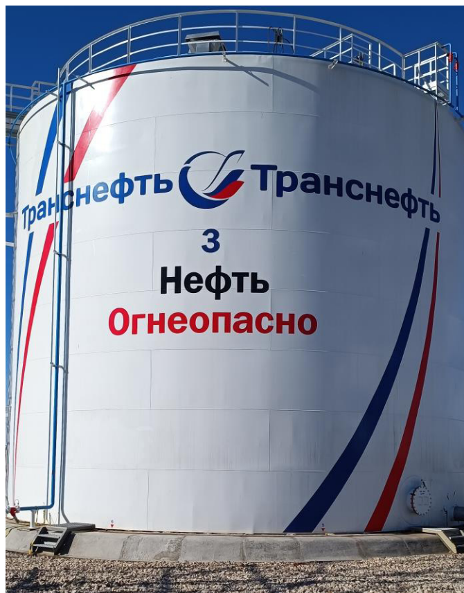
Рисунок 1 – Общий вид резервуара РВС-2000 зав.№ 3
