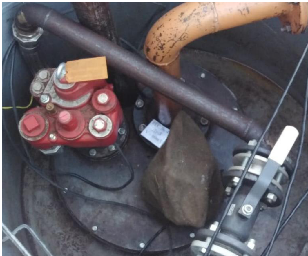
Рисунок 3 – Горловина резервуара РГС-60 зав.№ 4
