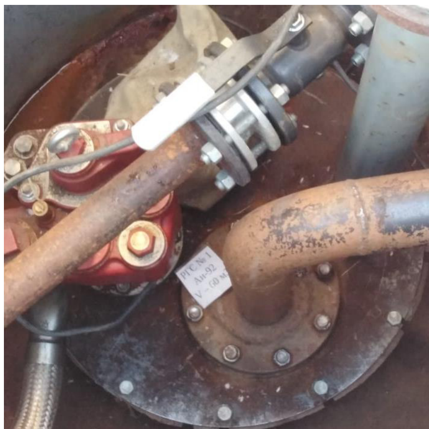
Рисунок 2 – Горловина резервуара РТС-60 зав.№ 1
