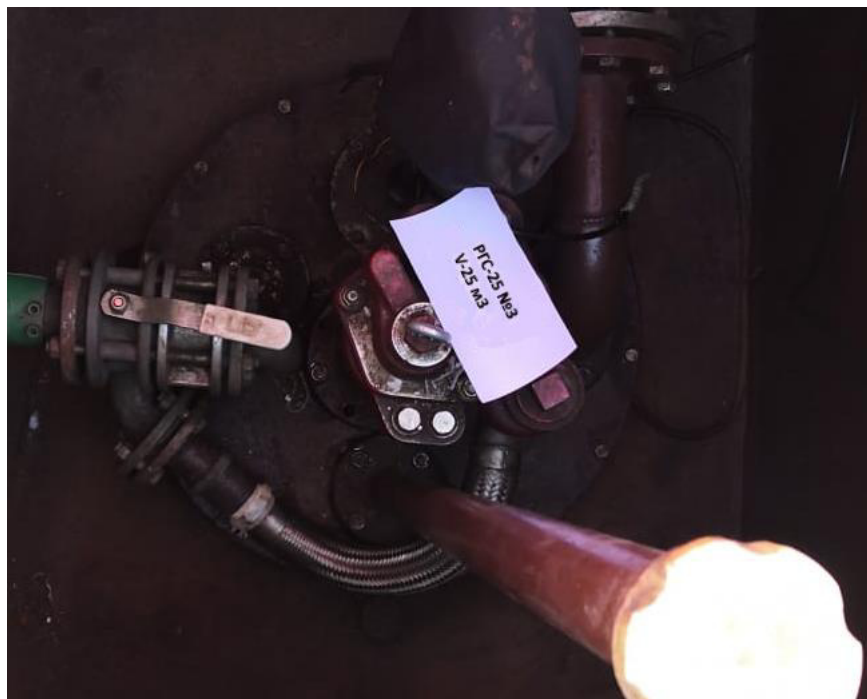
Рисунок 2 – Горловина резервуара РГС-25
