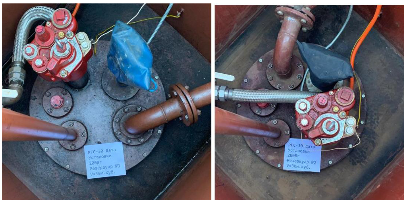
Рисунок 2 – Горловины резервуаров РГС-30 зав.№№1, 2
