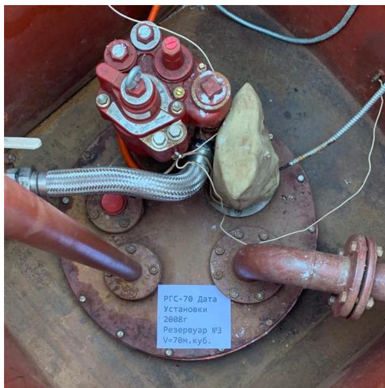
Рисунок 5 – Горловина резервуара РГС-70 зав.№3
