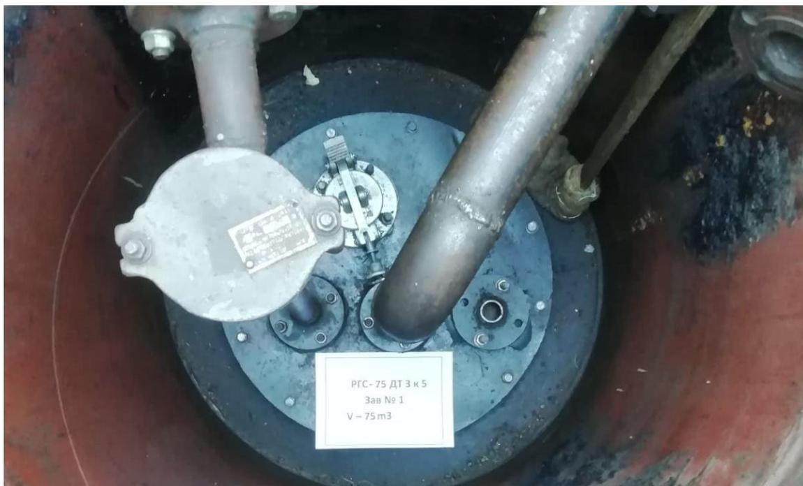
Рисунок 2 – Горловина резервуара РГС-75
