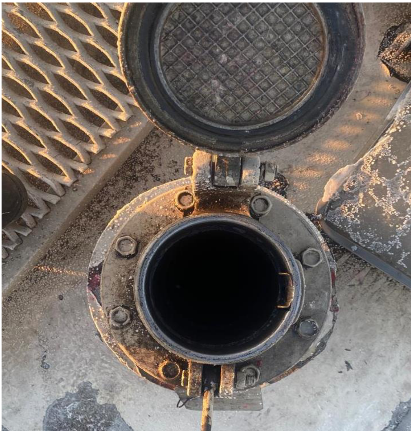
Рисунок 2 – Фотография горловины замерного люка резервуара РВС - 3000 заводской номер 444
