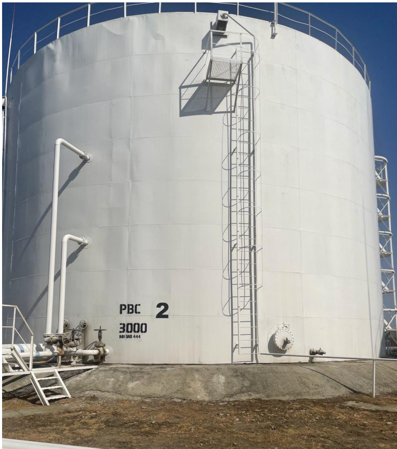
Рисунок 1 - Фотография общего вида резервуара РВС - 3000 заводской номер 444
