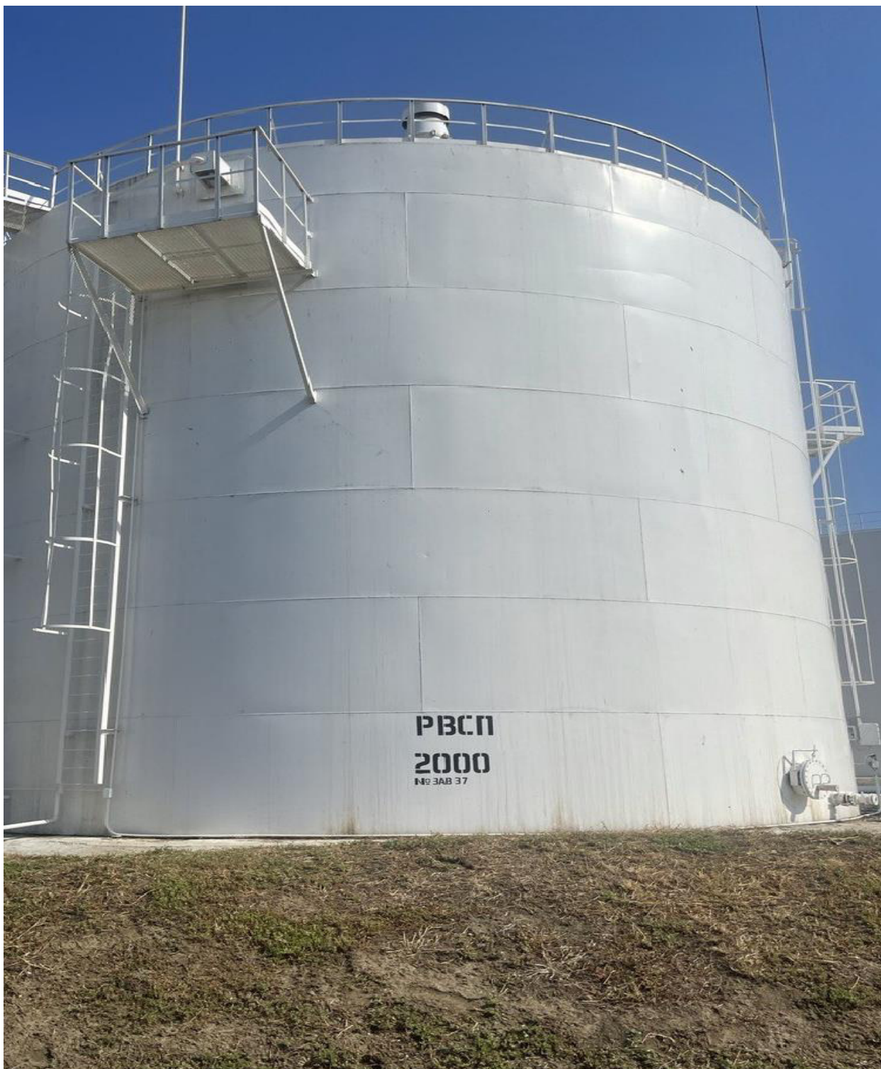
Рисунок 1 - Фотография общего вида резервуара РВСП - 2000 заводской номер 37
