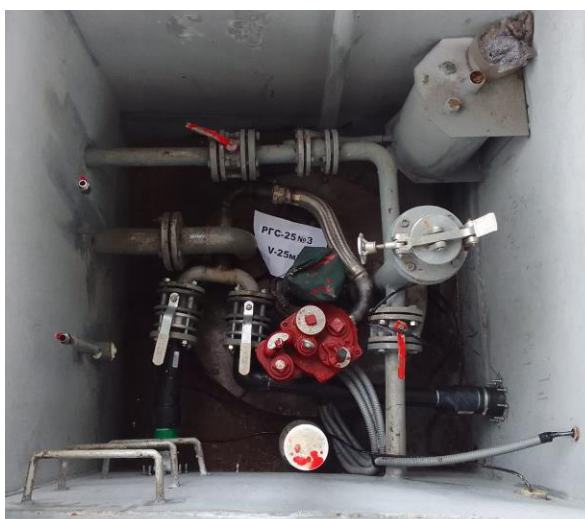
Рисунок 3 – Горловины резервуаров РГС-25 зав.№№ 3, 4
