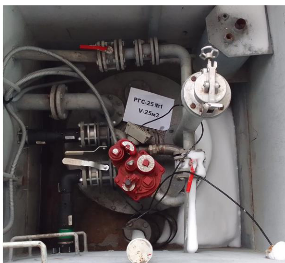
Рисунок 2 – Горловины резервуаров РГС-25 зав.№№ 1, 2
