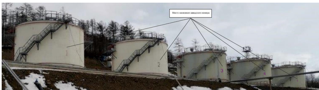
Рисунок 1 – Общий вид резервуаров вертикальных стальных цилиндрических РВС-1000 с указанием места нанесения заводских номеров
