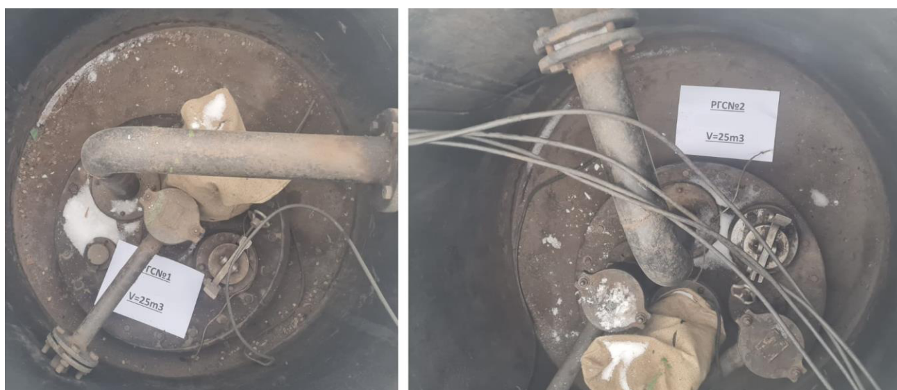
Рисунок 2 – Горловины резервуаров РГС-25 зав.№№1, 2
