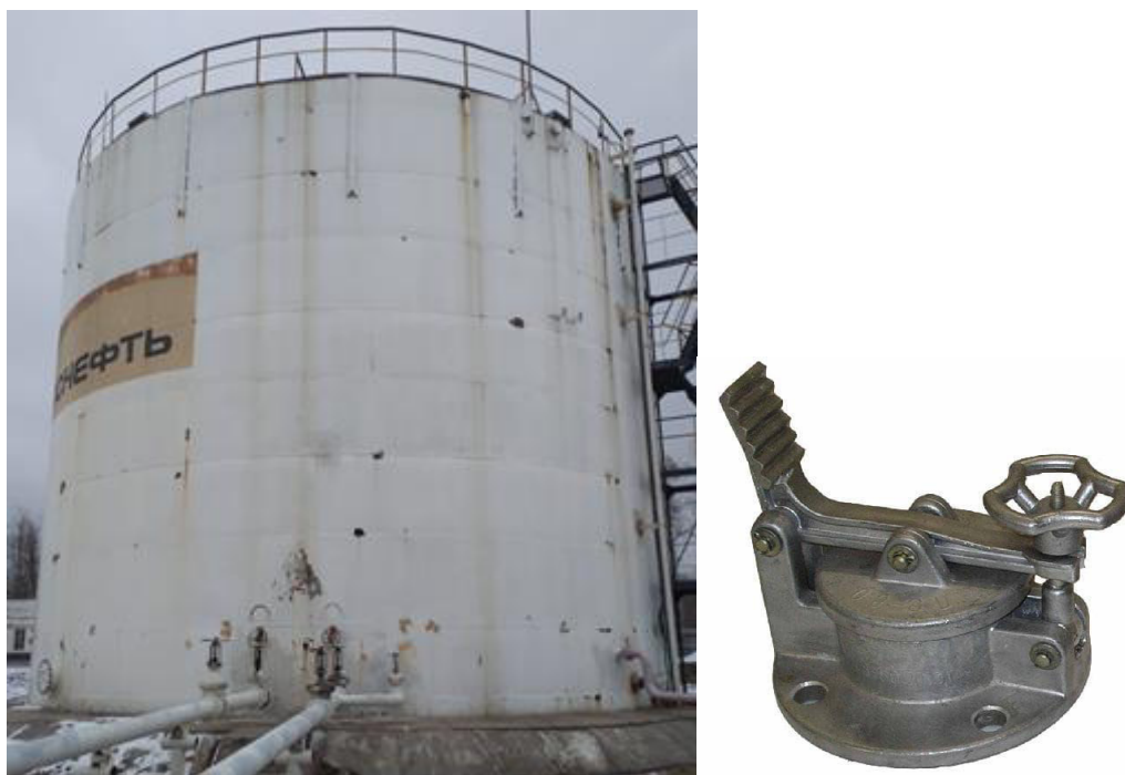
Рисунок 1 – Общий вид резервуара и замерного люка РВСП-2000
