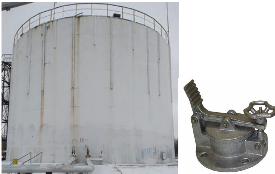
Рисунок 1 – Общий вид резервуара и замерного люка РВСП-3000
