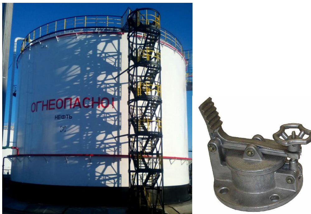
Рисунок 1 – Общий вид резервуара и замерного люка РВС-5000
