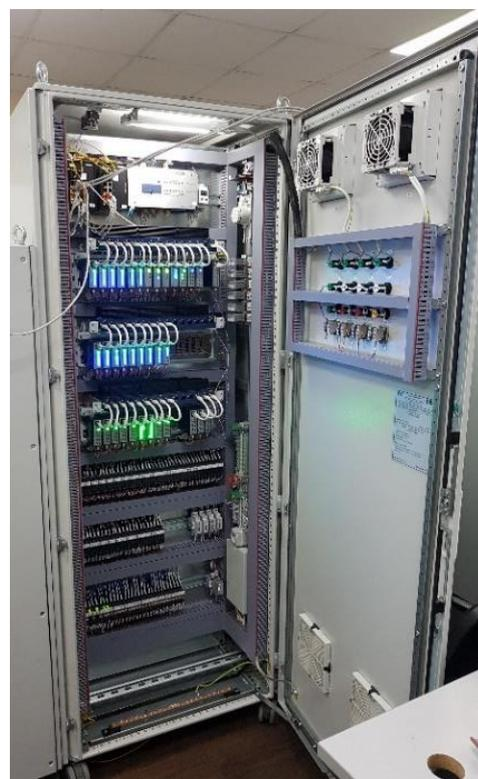
Рисунок 2 – Внешний вид ПТК (исполнения ЭЛАР-Э, ЭЛАР-АТ, ЭЛАР-Ц, ЭЛАР-ТМ, ЭЛАР-ПК)
