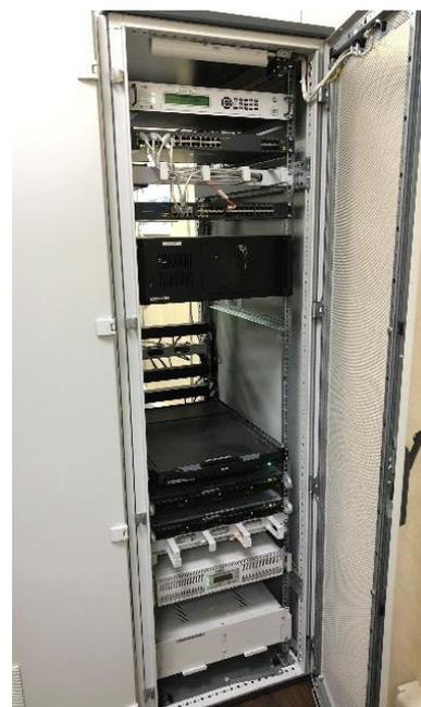
Рисунок 4 – Внешний вид ПТК (исполнения ЭЛАР-Э, ЭЛАР-АТ, ЭЛАР-Ц, ЭЛАР-ТМ, ЭЛАР-ПК)
