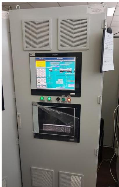
Рисунок 3 – Внешний вид ПТК (исполнения ЭЛАР-Э, ЭЛАР-АТ, ЭЛАР-Ц, ЭЛАР-ТМ, ЭЛАР-ПК)
