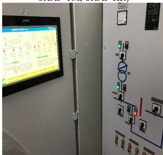
Рисунок 5 – Внешний вид ПТК (исполнения ЭЛАР-Э, ЭЛАР-АТ, ЭЛАР-Ц, ЭЛАР-ТМ, ЭЛАР-ПК)
