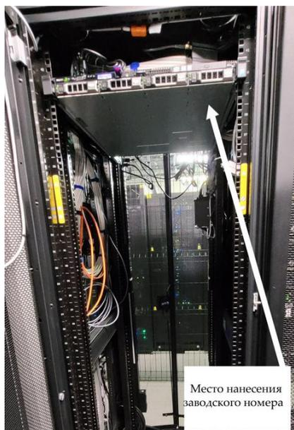
Рисунок 1 - Общий вид сервера ИВК ООО «МТС ЭНЕРГО» с указанием места нанесения заводского номера.
