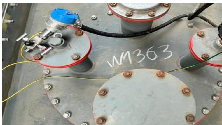
Рисунок 5 – Фотография горловины и заводского номера резервуара стального горизонтального цилиндрического РГС, модификации РГС-200 с зав. № 1363
