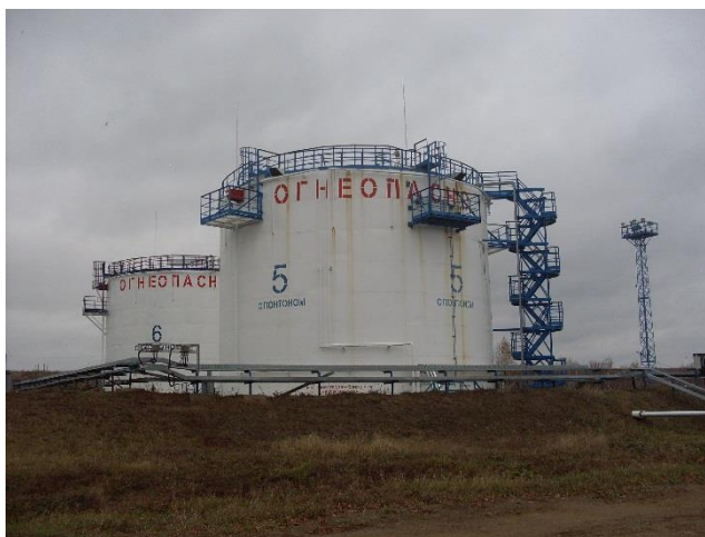
Рисунок 1 - Общий вид резервуаров стальных вертикальных цилиндрических РВС-2000.
