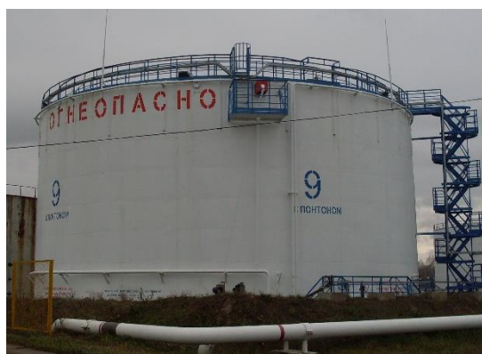
Рисунок 3 - Общий вид резервуаров стальных вертикальных цилиндрических РВС-5000.
