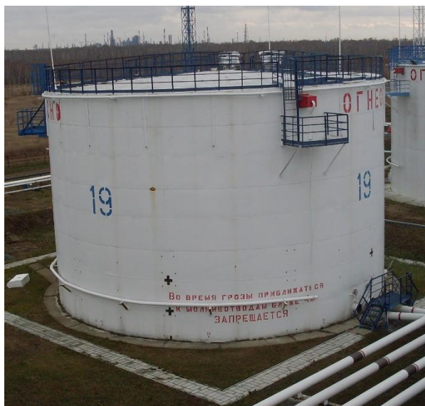
Рисунок 2 - Общий вид резервуаров стальных вертикальных цилиндрических РВС-3000.
