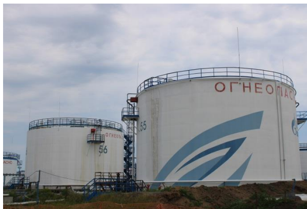
Рисунок 1 - Общий вид резервуара стального вертикального цилиндрического РВС-3000.
