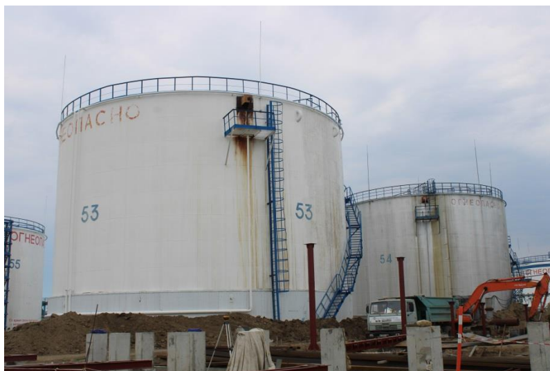
Рисунок 2 - Общий вид резервуаров стальных вертикальных цилиндрических РВС-5000.
