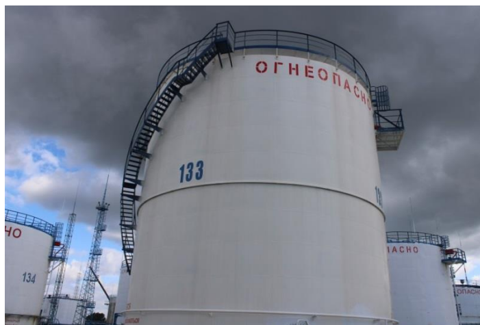
Рисунок 1 – Общий вид резервуара
