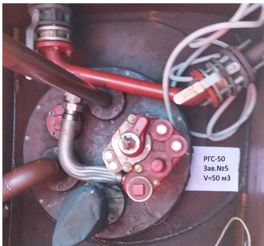
Рисунок 2 – Горловина резервуара РГС-50 зав.№ 5
