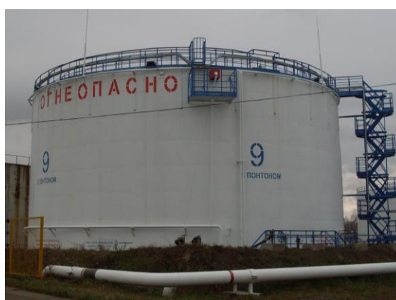
Рисунок 3 - Общий вид резервуара стального вертикального цилиндрического РВСП-5000
