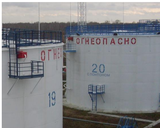
Рисунок 2 - Общий вид резервуара стального вертикального цилиндрического РВСП-3000
