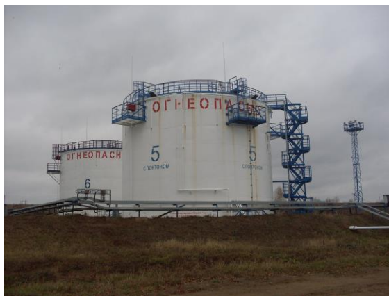
Рисунок 1 - Общий вид резервуаров стальных вертикальных цилиндрических РВСП-2000
