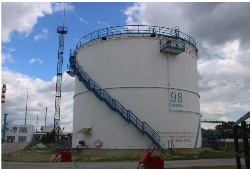
Рисунок 2 – Общий вид резервуаров стальных вертикальных цилиндрических РВС-5000.
