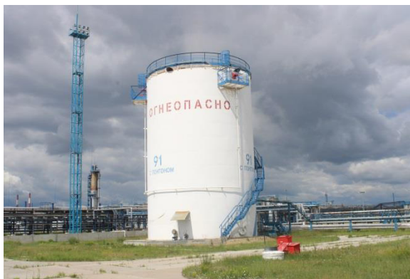
Рисунок 1 – Общий вид резервуара стального вертикального цилиндрического РВС-2000.
